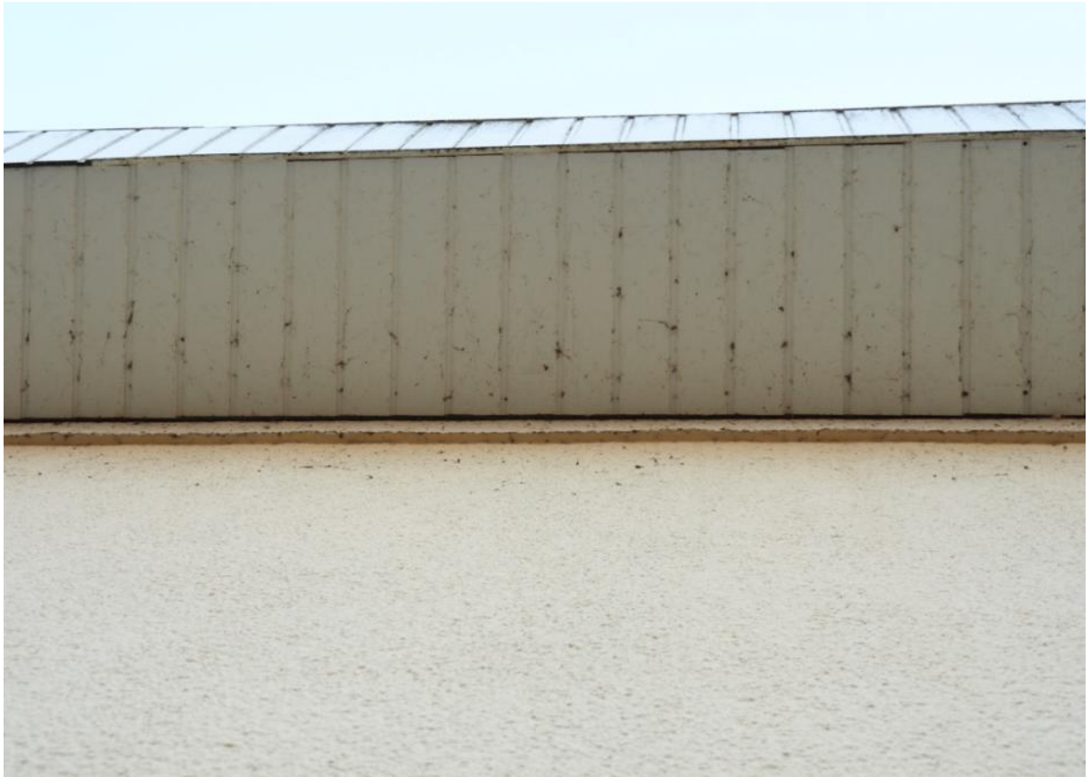
Abbildung 12: Holzverkleidung. Spalten könnten unter Umständen in Hohlräume hinter der Holzverkleidung führen (23.03.2016).
