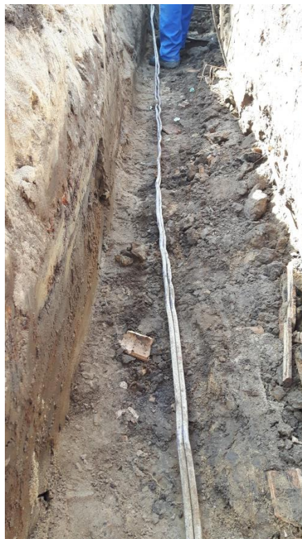
Abbildung 2+3: Fotos vom 03.07.2019, Blick in den Suchschlitz zur Auffindung der Heizölleitung zum Wohnhaus "Heckenweg 1", Leitung intakt angetroffen, keine Hinweise auf Leckagen oder Tropfverluste
