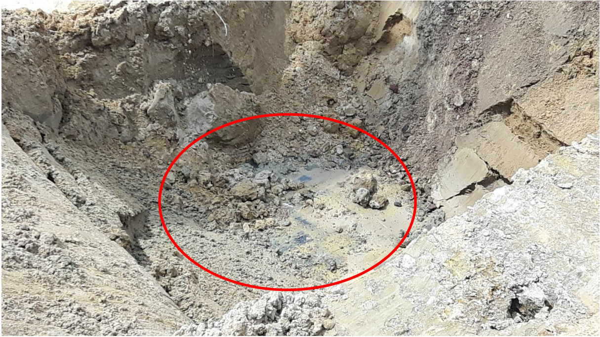
Abbildung 6: Foto vom 18.06.2019, Blick in die Aushubgrube des Heizöltanks, Feststellung von verfärbten und geruchlich auffälligen Bodenschichten in der Sohle (KP Sohle NW entnommen)
