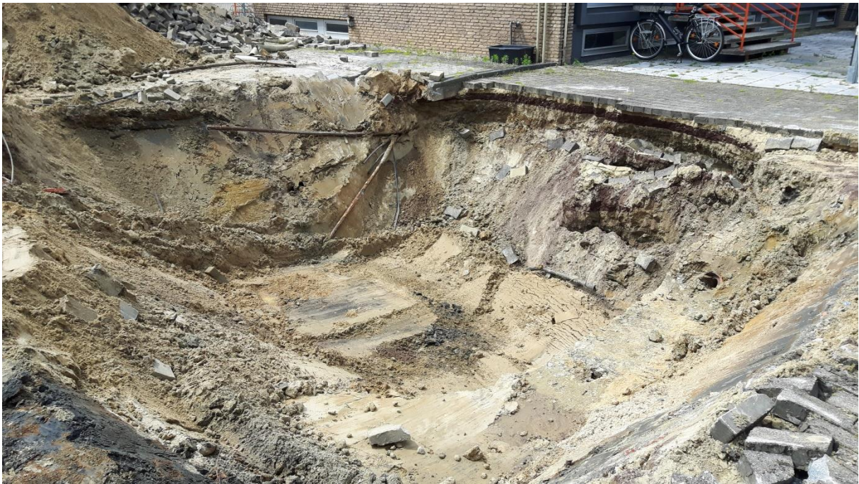
Abbildung 7: Foto vom 18.06.2019, Blickrichtung Nordwest auf das Bürogebäude, Baugrubenzustand zum Ende der Aushubtätigkeiten, am unteren Bildrand sind die verfärbten und geruchlich auffälligen Bereiche zu erkennen
