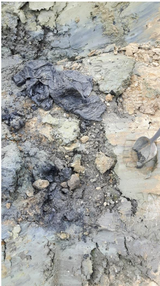
Abbildung 5+6: Fotos vom 03.07.2019, Fund von Ölverschmierten Tuchresten und vereinzelt "Ölfallen" im anstehenden Boden, Position ca. 2,5 m unter GOK in der Südwestecke der Tankgrube, unterhalb der ehem. Zapfsäule
