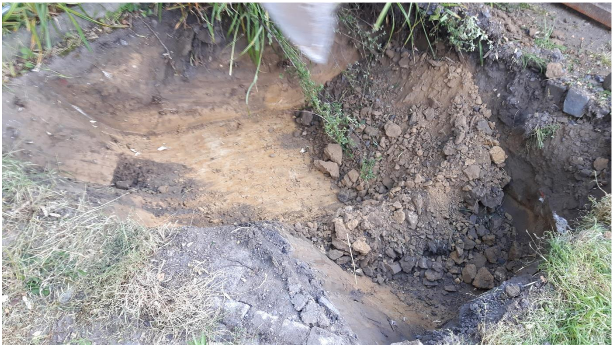
Abbildung 1: Foto vom 02.07.2019, Blick in den Suchscharf an der südöstlichen Grundstücksgrenze zur Auffindung der vermeintlich geplanten Tankstelle (ca. 1950), es waren keine Auffälligkeiten festzustellen
