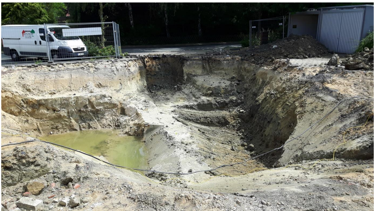
Abbildung 11: Foto vom 17.07.2019, Blickrichtung Osten zum Heckenweg, zu sehen sind der weitere Aushub im Bereich der Zufahrt bis zur Grundstücksgrenze und der weitere Aushub im Bereich geringfügiger Restbelastungen (mittig-rechts im Bild)
