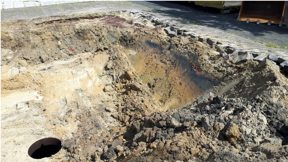
Abbildung 1: Foto vom 18.06.2019, Blickrichtung Nordost (Parkbuchten am Heckenweg im Hintergrund), Verfärbungen in der Böschungswand (KP Böschung Ost entnommen), am linken Bildrand ist die Öffnung des Heizöltanks zu erkennen
