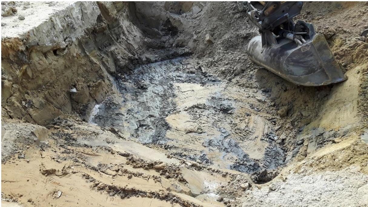
Abbildung 4: Foto vom 03.07.2019, Blick in die Aushubgrube der Heizöl- und Dieseltanks, Aushub bis auf den anstehenden, sauberen gewachsenen Boden in ca. 3,5 m Tiefe, Verdachtspunkte ausgehoben
