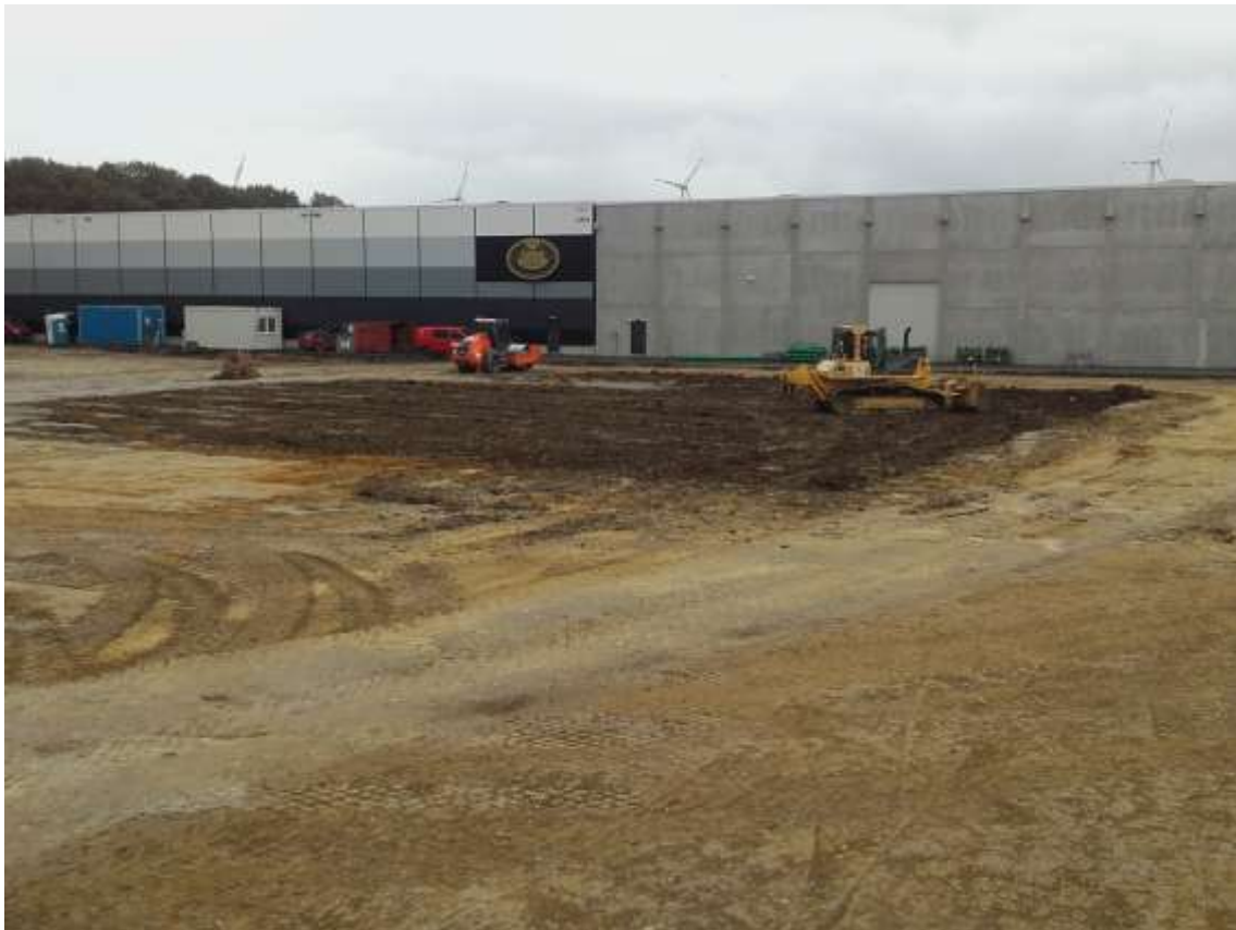
Abbildung 1: Einbau des Z 2-Materials
